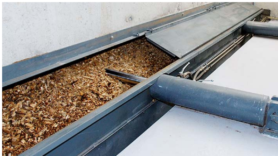
Příčné posouvání dřevní štěpky z vynašeče s posuvnou podlahou
